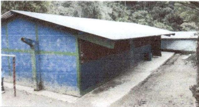
Foto 1: Lámina troquelada calibre 26 instalada en el techo de la escuela
